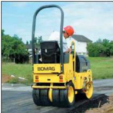
BW 90 AC-2: Zagęszczanie i zamykanie nawierzchni w jednym biegu roboczym.
