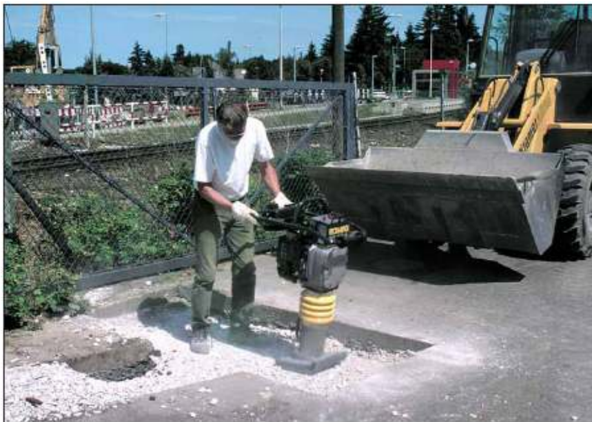
BT 65/4 wyróżnia się zwłaszcza dobrym posuwem naprzód, bardzo dużą siłą uderzeniową i swoimi szczególnie niskimi kosztami eksploatacji
